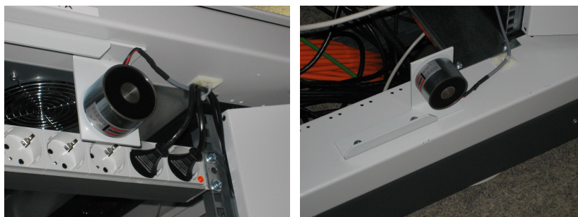
Haltemagnete oben und unten halten die Türen mit insgesamt 840 N (= 84 kp).
